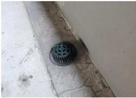
ภาพที่ 40 ตะแกรงครอบตามรูท่อระบายน้ำทิ้ง
