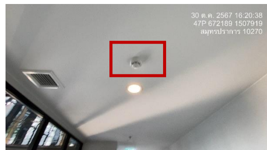
ภาพที่ 25 อุปกรณ์ระบบตรวจสอบและแจ้งเหตุเพลิงไหม้
