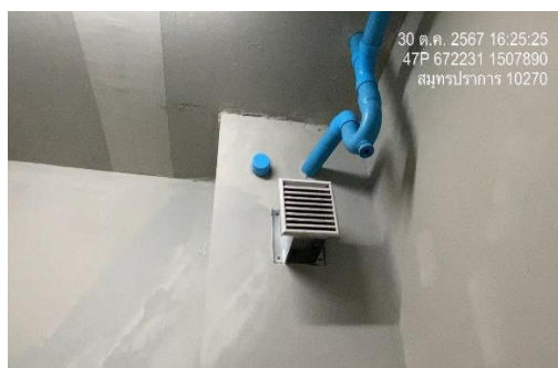
ภาพที่ 21 ระบบบำบัดอากาศเสียจากห้องพักขยะ
