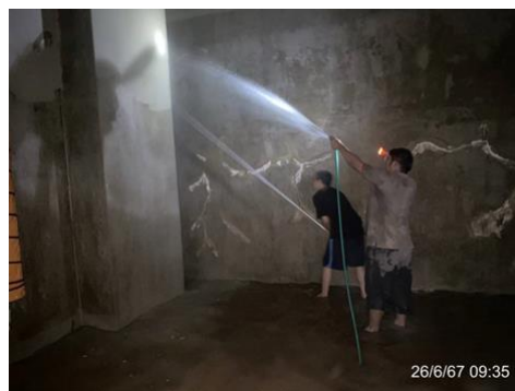
ภาพที่ 11 การล้างถังสำรองน้ำใช้ของโครงการ
