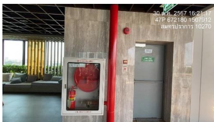
ภาพที่ 25 อุปกรณ์ระบบตรวจสอบและแจ้งเหตุเพลิงไหม้ (ต่อ)
